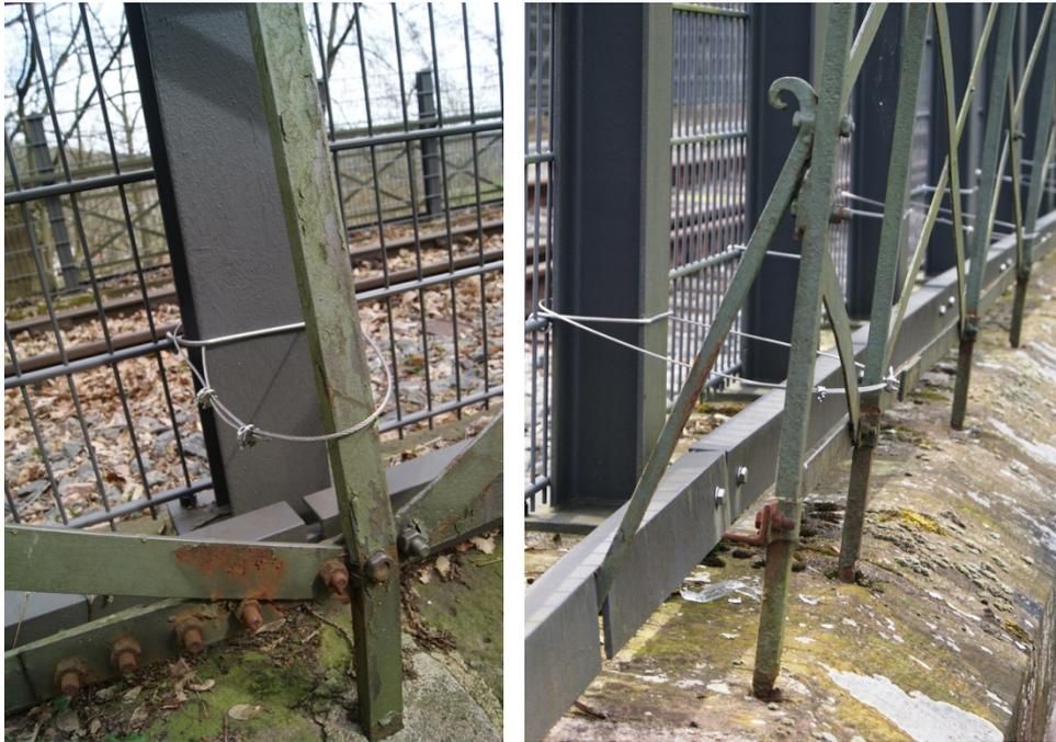
Im Prüfbericht wurde daraufhin nachgetragen, dass nach der Sicherung der Geländer eine durch Abrosten der Geländerpfostenfüße bedingte Verkehrsgefährdung nicht mehr vorliege.
