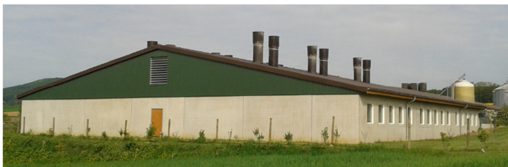
Abbildung 28–1: Geförderte Maßnahme (Schweinestall) in Nordhessen, Investitionsvolumen 800.000 Euro
