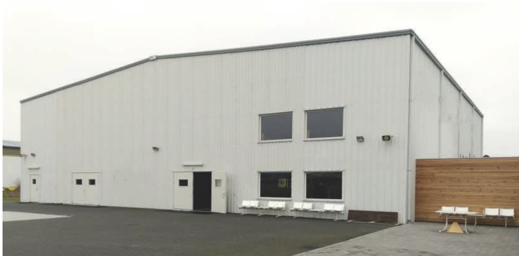
Abbildung 9: Neue Halle des Unternehmens (Quelle: Regierungspräsidium Kassel, Aufnahme vom 7. Februar 2017)
