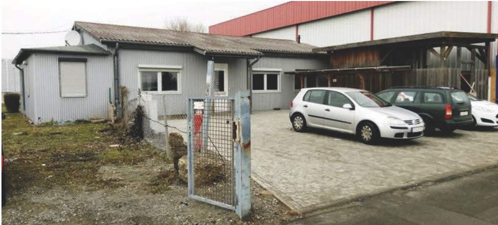
Abbildung 10: Altliegenschaft - Bistro und Verwaltungsgebäude (Quelle: Regierungspräsidium Kassel, Aufnahme vom 8. Februar 2017)
