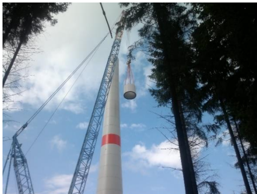
Ansicht 159: Bau einer Windkraftanlage in Bad Endbach (Aufnahme vom 14. Juli 2014)
