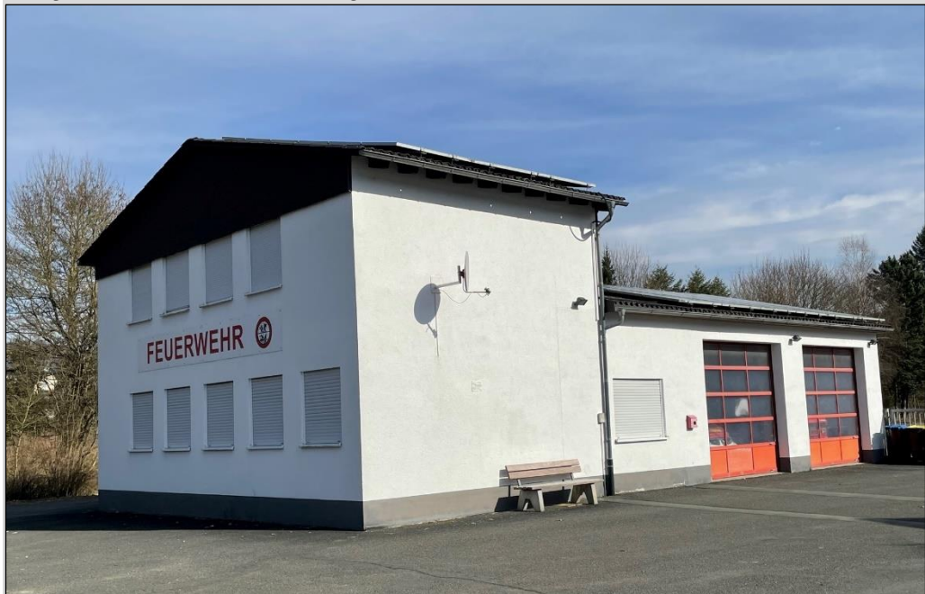
Ansicht 92: Altes Feuerwehrgerätehaus Mittenaar Ortsteil Offenbach (Quelle: Gemeinde Mittenaar)
