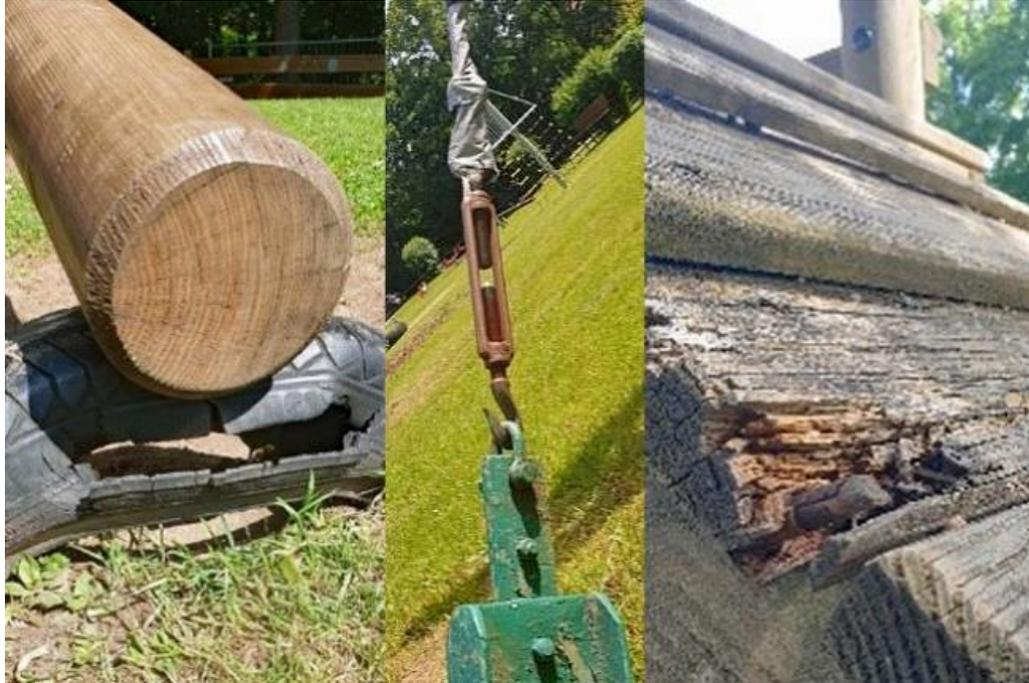
Ansicht 76: Beispiele für sicherheitsrelevante Mängel an Spielgeräten, v. l. n. r. defekter Puffer an einer Holzzippe, bodennahes einseitig offenes Spannschloss mit aufragender Spitze an einer Seilbahn, Holzverrottung am Aufstieg eines Kletterturms (Aufnahmen Mai bis Juni 2023)
